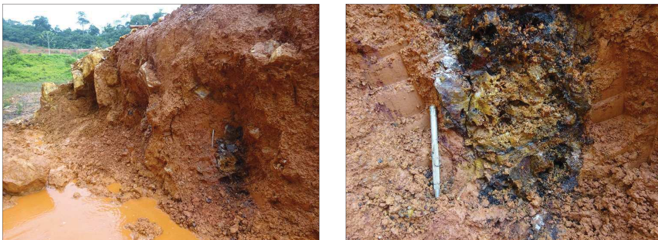
Figure 26. Localisation des niveaux oxydés à quartz-oxydes de fer au sein de la zone filonienne, montrant des textures cariées à nombreux boxworks, résultant de l'altération de sulfures préexistants. Lors des tests à la batée, ces facies se sont révélés être les plus minéralisés en or
