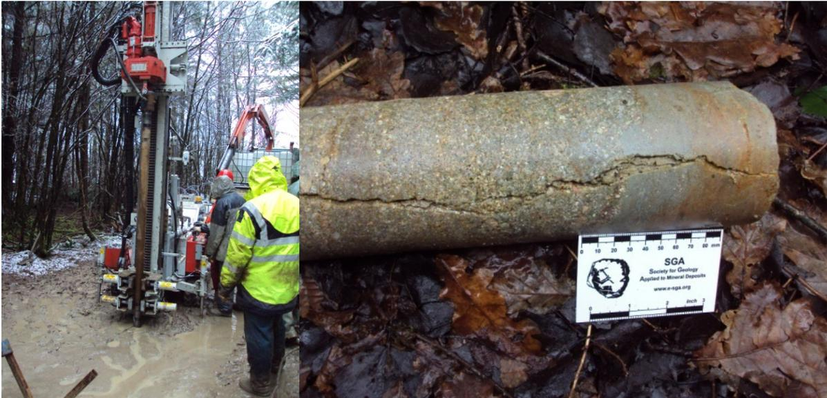
Figure 6 : Sondage carotté sur le permis d'Antully (Saône-et-Loire, France) pour le compte de la société Garrot-Chaillac et carotte de sondage (Cliché : M. Gigoux, Univ.d'Orsay-BRGM).
